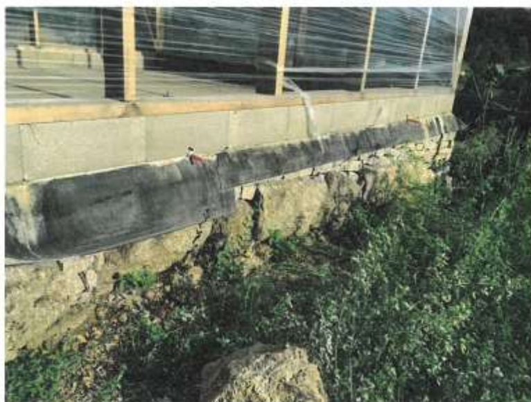
foto 1: dostavba stávajících základů, jižní strana (srpen 2016)
