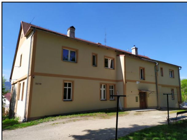
foto 1 BD č.p.72 – severní průčelí
