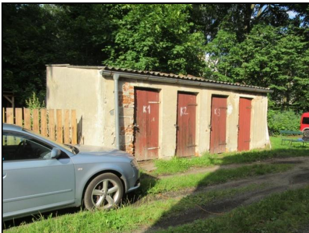
foto 25 pozemky u BD - vedlejší stavba (1)
