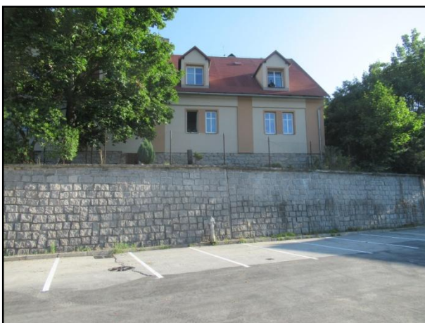
opěrná zeď pod č.p. 72 - pohled areálu sociálního bydlení (1)
