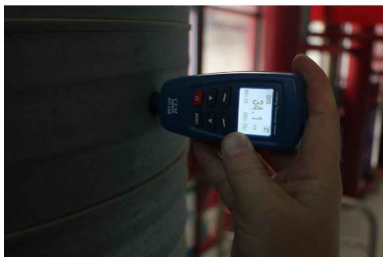
Obr. F-22 Kontrola tloušťky pozinkování vzduchotechnických rozvodů v prostoru schodiště k tobogánům.
