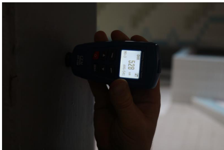
Obr. F-19 Kontrola tloušťky laku nosné konstrukce v místě vstupu do prostoru dojezdu tobogánů.
