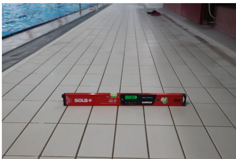
Obr. F-1 Kontrola sklonu bazénového ochozu plaveckého 50m bazénu.
