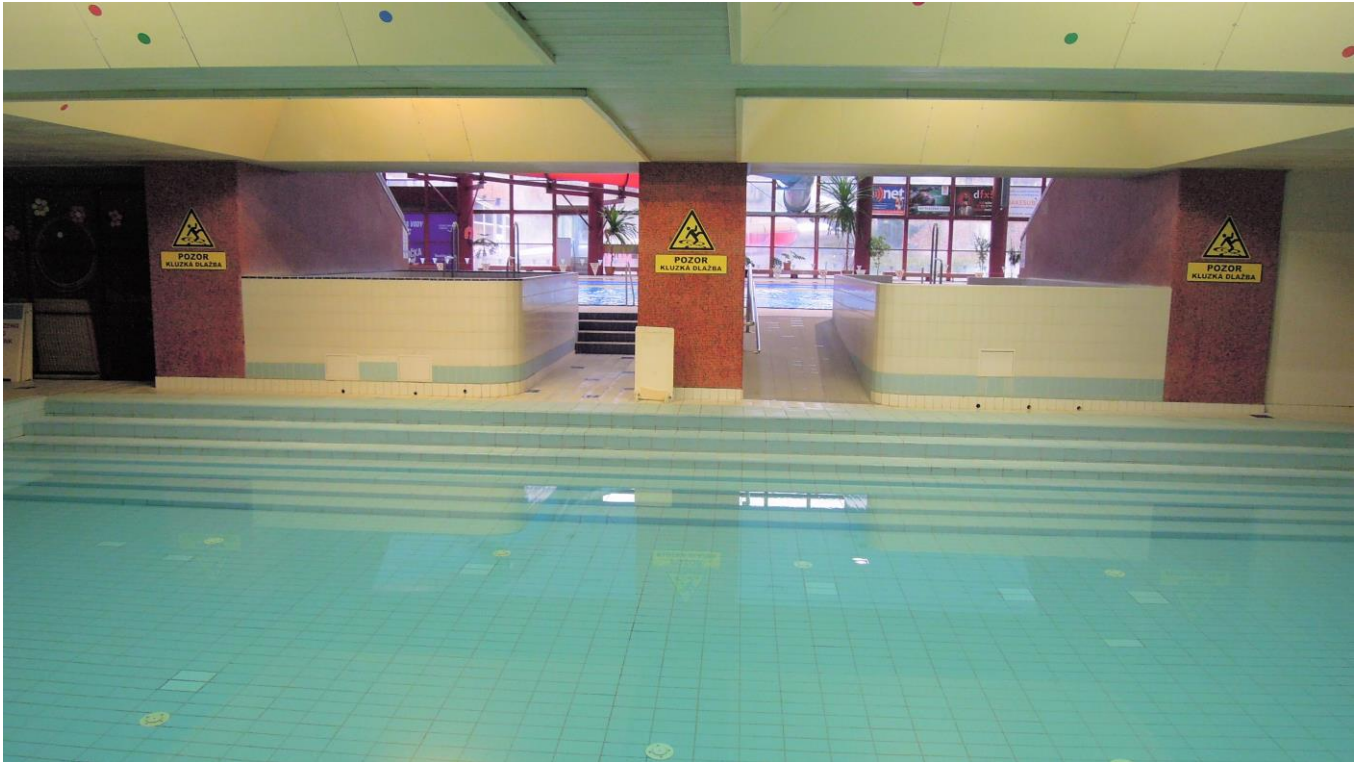
výukový bazén pohled od posilovny - stávající stav
