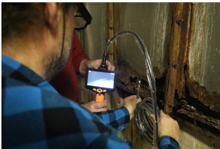
Obr. F-33 Kamerová inspekce potrubí systému vzduchotechnických rozvodů.
