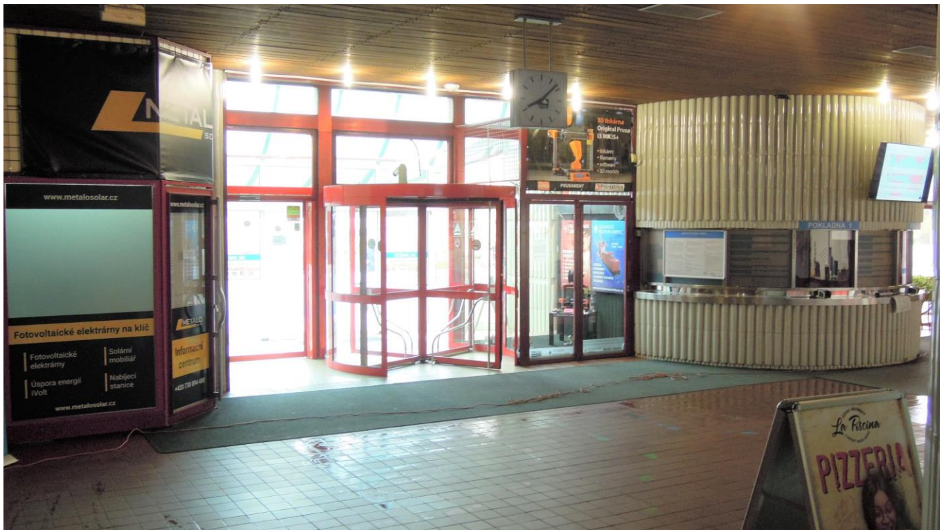
pohled na vstup - stávající stav
