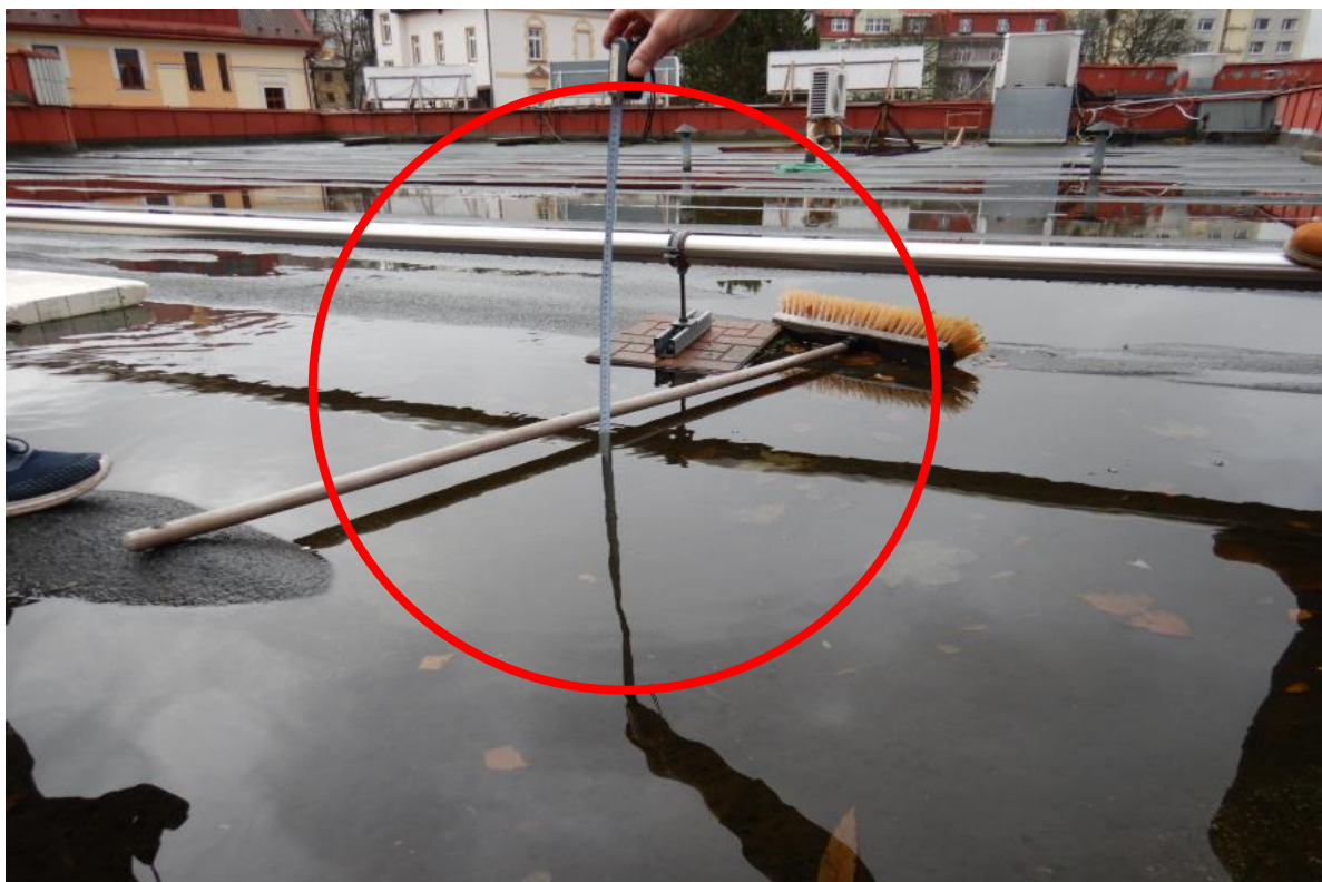
Obr. C-33 Detailní pohled na asfaltový povrch ploché střechy nad prostorem sociálního zázemí.
