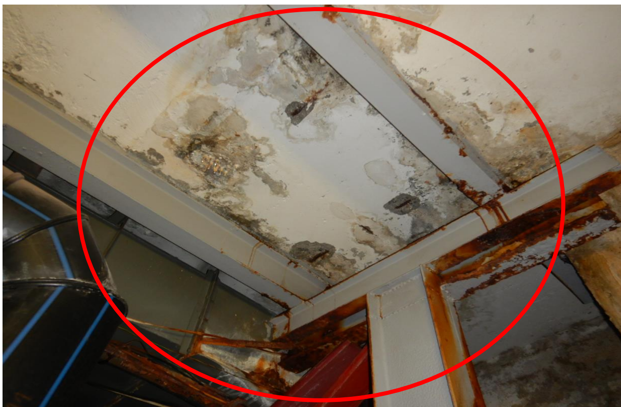
Obr. C-13 Pohled na provizorní podepření dětského výukového bazénu a dna vířivek ocelovou konstrukcí.
