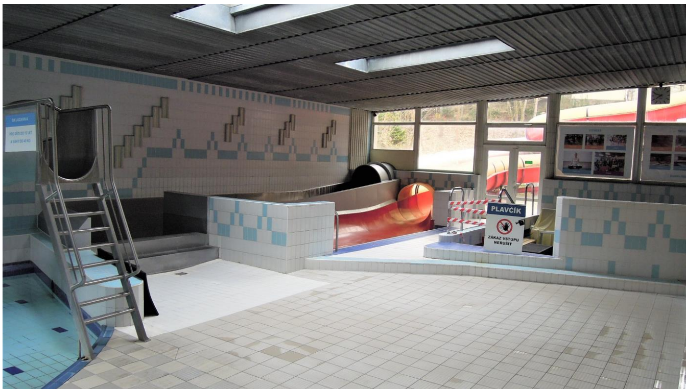
dojezd tobogánu - stávající stav
