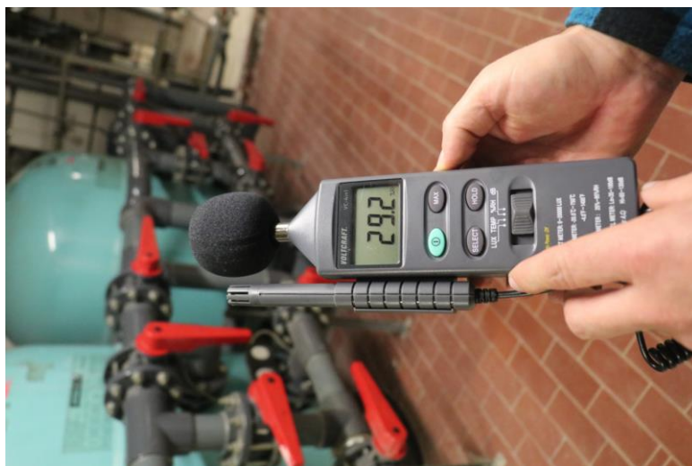
Obr. F-15 Kontrola relativní vlhkosti v prostorách strojovny MPB.
