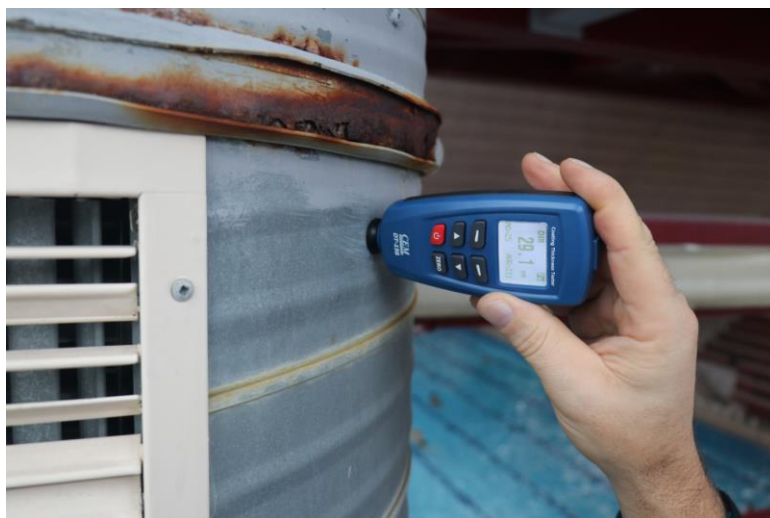
Obr. F-24 Kontrola tloušťky pozinkování potrubí v prostoru schodiště k tobogánům.
