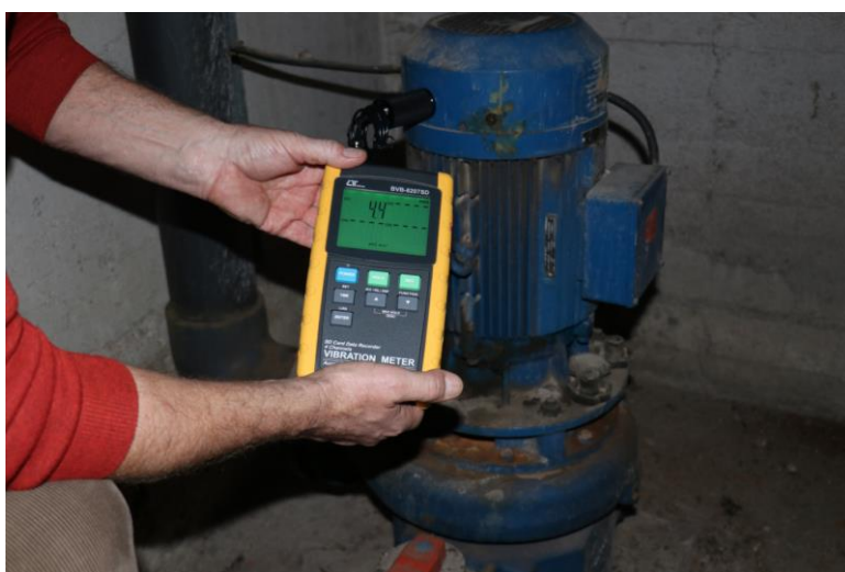
Obr. F-32 Kontrola vibrační čerpadla tobogánu.
