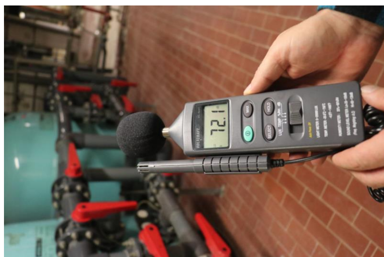
Obr. F-16 Kontrola úrovně hluku v prostorách strojovny MPB.
