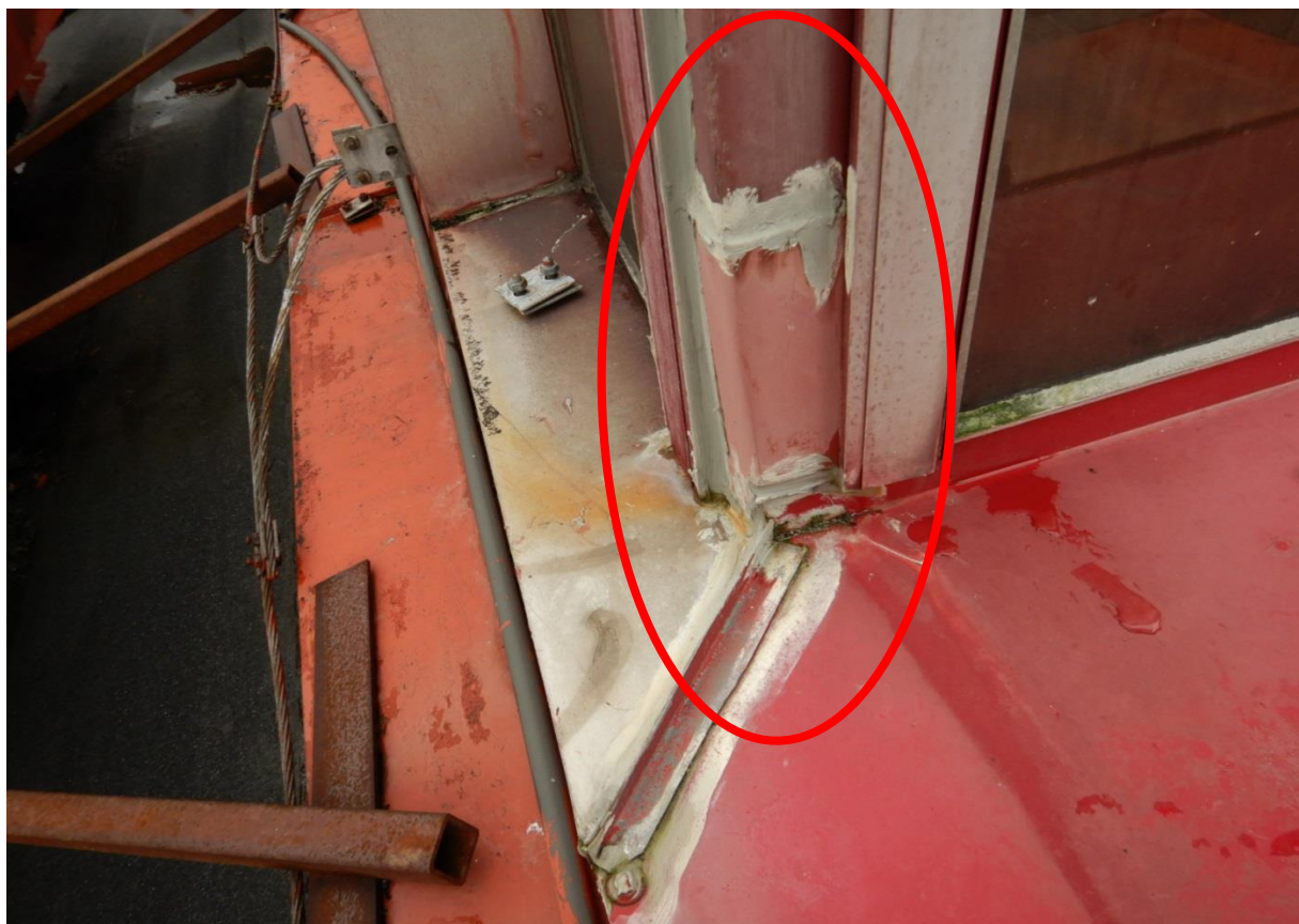
Obr. C-37 Pohled na provizorní opravu opláštění plaveckého 50m bazénu.
