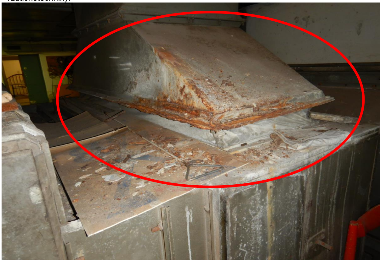
Obr. C-48 Detailní pohled na napojení stávající vzduchotechnické jednotky na potrubí vzduchotechniky.
