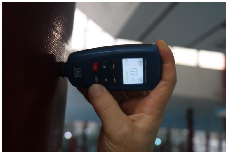
Obr. F-21 Kontrola tloušťky laku nosného sloupu střechy plaveckého 50m bazénu.
