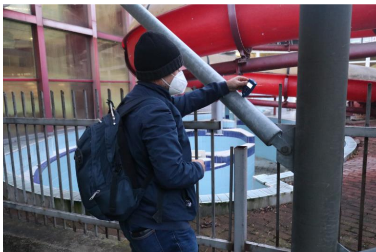
Obr. F-25 Kontrola tloušťky pozinkování potrubí nosné konstrukce tobogánu ve venkovním prostředí u atrakce divoká řeka.
