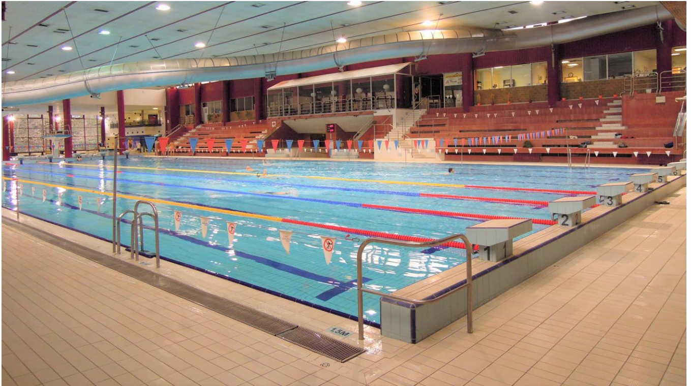
plavecký bazén 50 m - stávající stav
