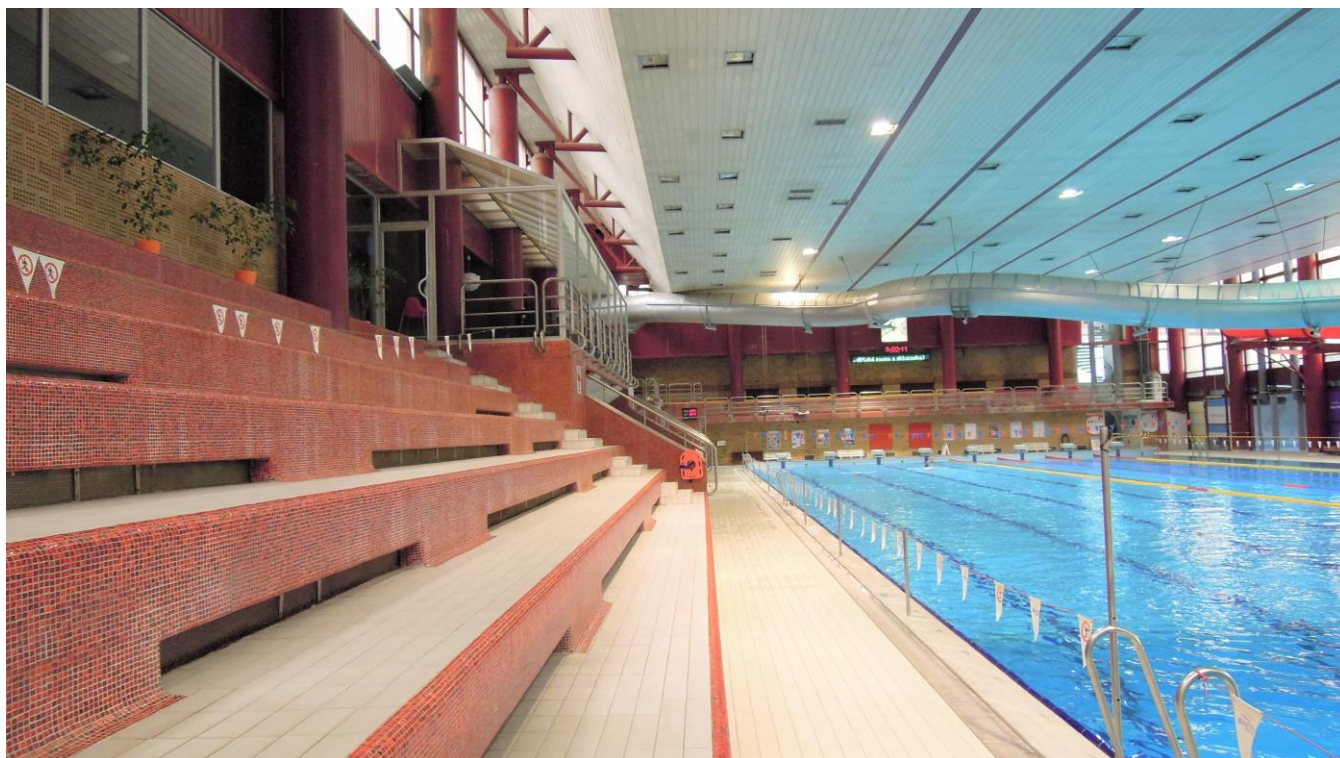
plavecký bazén 50 m - stávající stav
