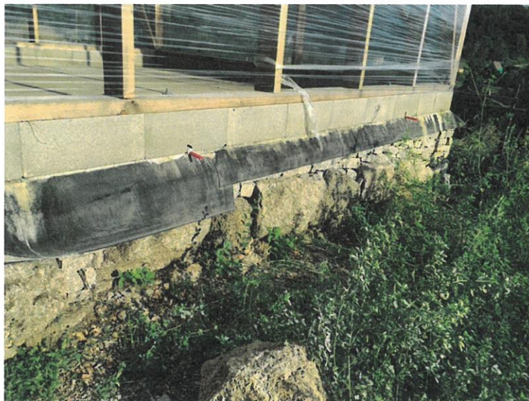
foto 1: dostavba stávajících základů, jižní strana (srpen 2016)
